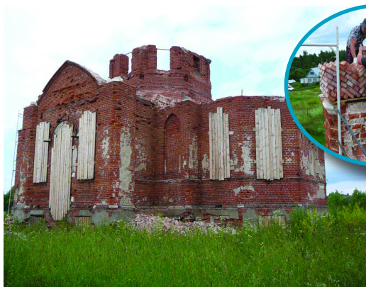
23 июня 2013 г. После очистки стен храм перестал выглядеть заброшенным...
