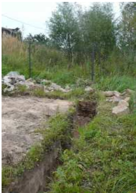
Начато обустройство дренажной системы
