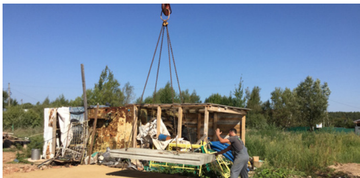
Установка плит – основы для сооружения котельной
