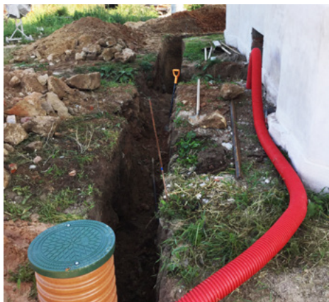
Обустройство дренажной системы
