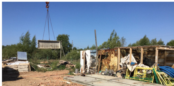
Установка плит – основы для сооружения котельной
