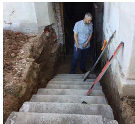
Установлен лестничный марш для спуска в нижний ярус храма
