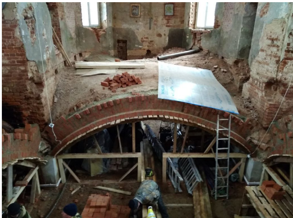
Фото 1. Общий вид фронта работ по ремонту кладки перекрытия со стороны западного входа.
