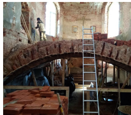
Фото 2. Опалубка для заделки сквозного проема в кладке перекрытия в районе алтаря.
