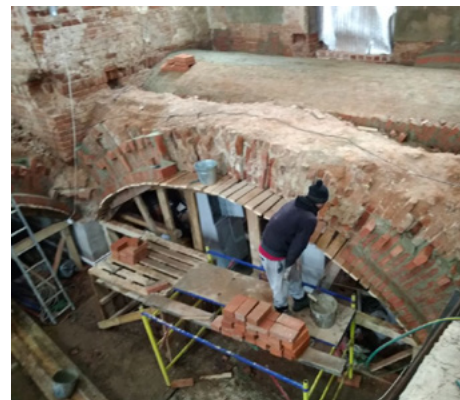
Фото 4. Восстановление перекрытия с южной стороны храма.
