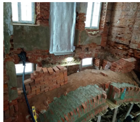
Фото 3. Восстановление перекрытия с северной стороны храма.
